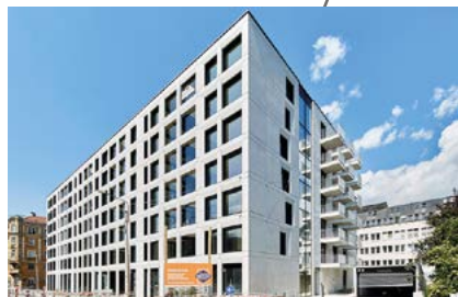
6020 Innsbruck (Auszug) Wohn- und Geschäftsgebäude Anton-Melzer-Straße 10
